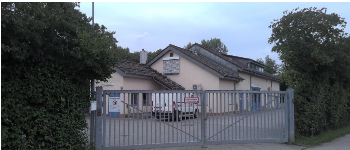
Abbildung 41 Kläranlage Trebur (eigene Aufnahme IU)
